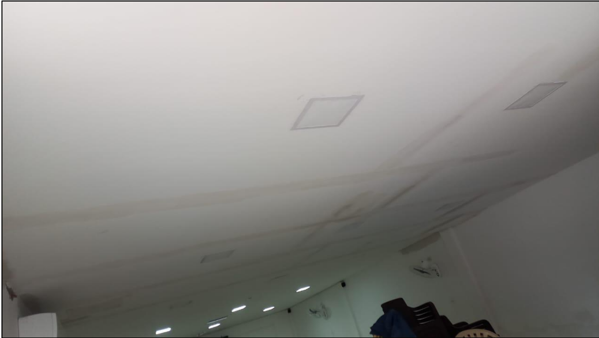
Ilustración 21: Cielo raso en drywall
