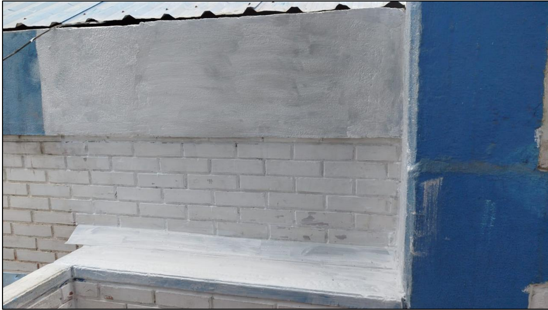
Ilustración 15: Canal escaleras, limpieza e impermeabilización.
