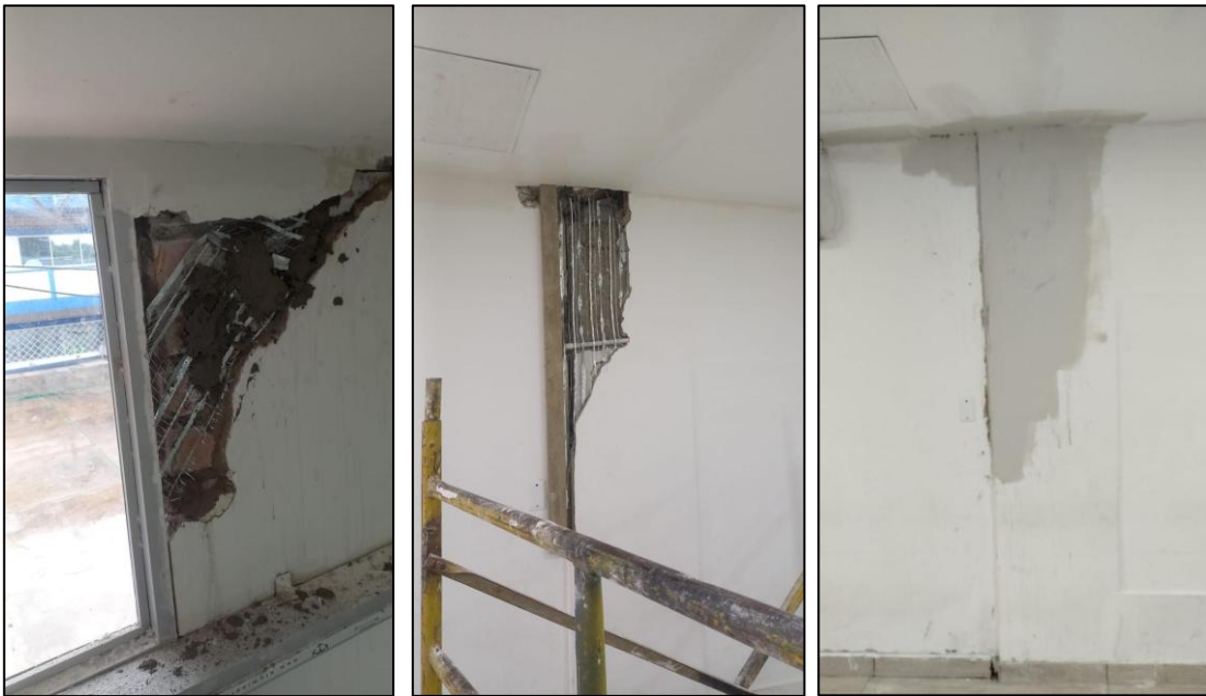
Ilustración 20: Instalación de malla para reforzamiento temporal
