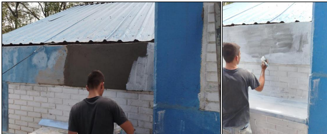
Ilustración 15: Canal escaleras, limpieza e impermeabilización.
