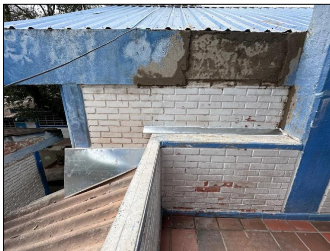
Ilustración 16: Resane, flanche e impermeabilización con acrílico blanco
