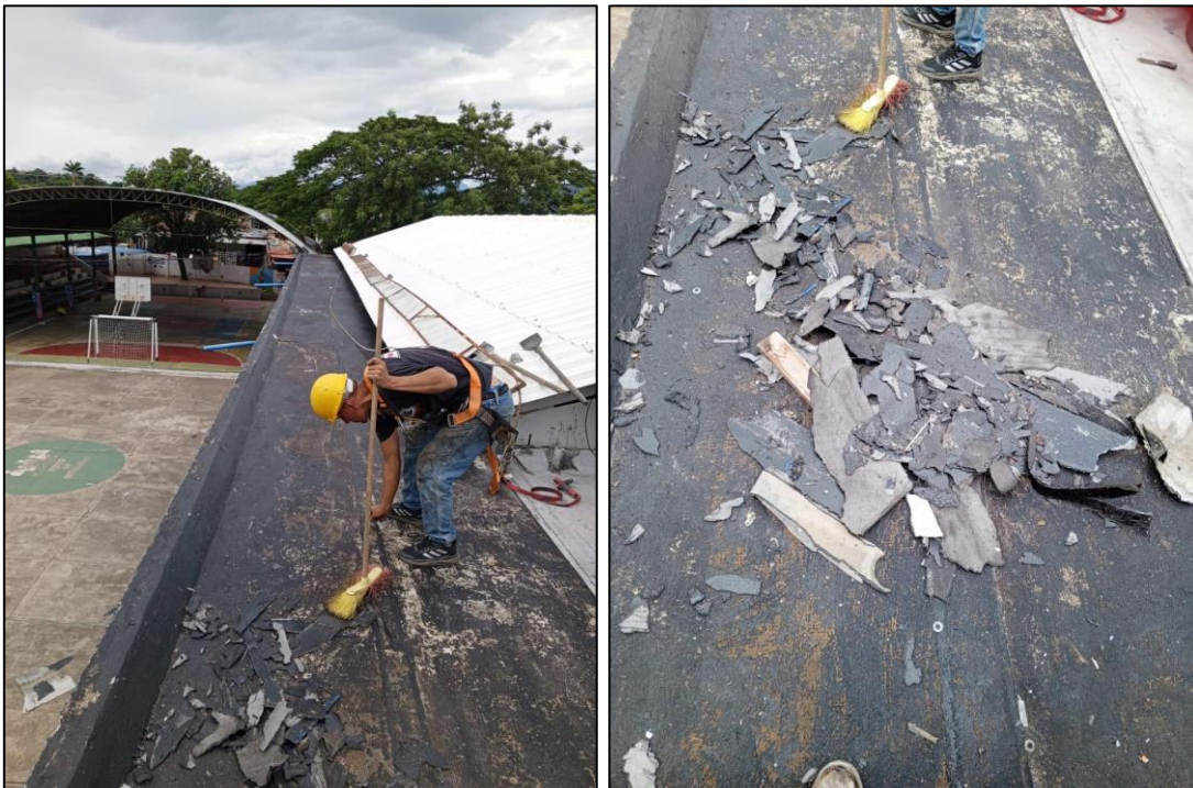
Ilustración 2: Desmonte y escarilamiento de manto existente
