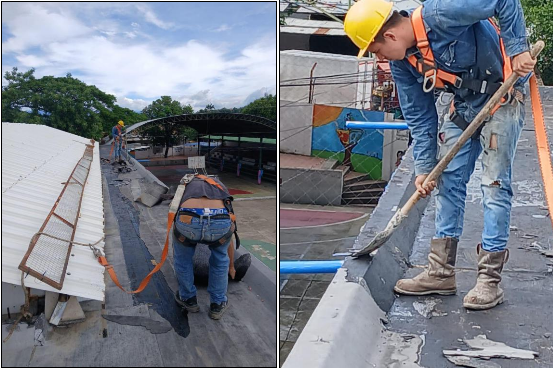
Ilustración 1: Desmonte y escarilamiento de manto existente
