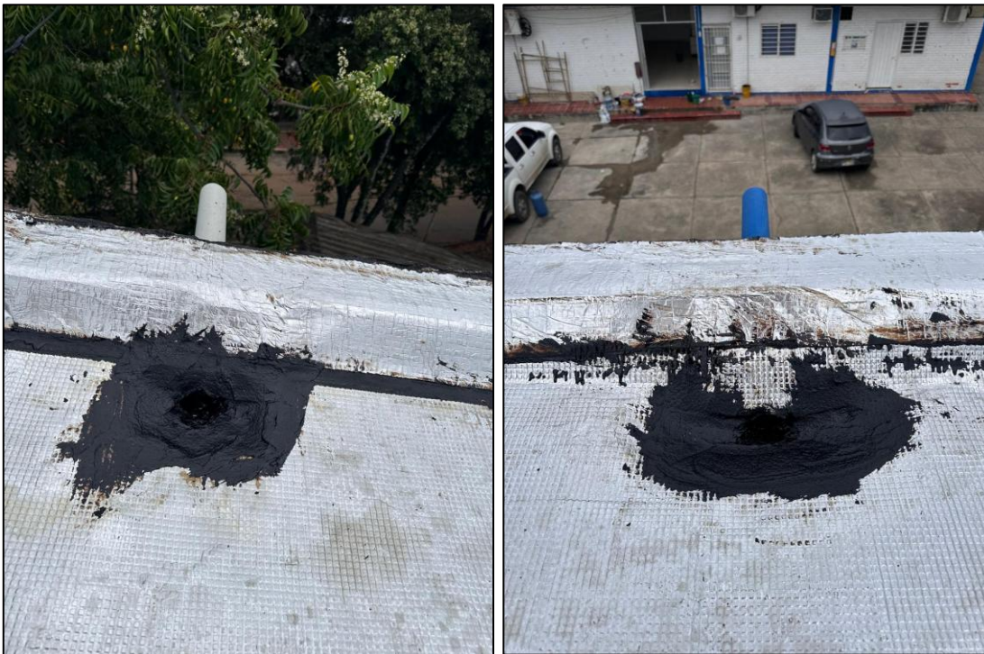
Ilustración 8: Bajantes con manto asfáltico y emulsión
