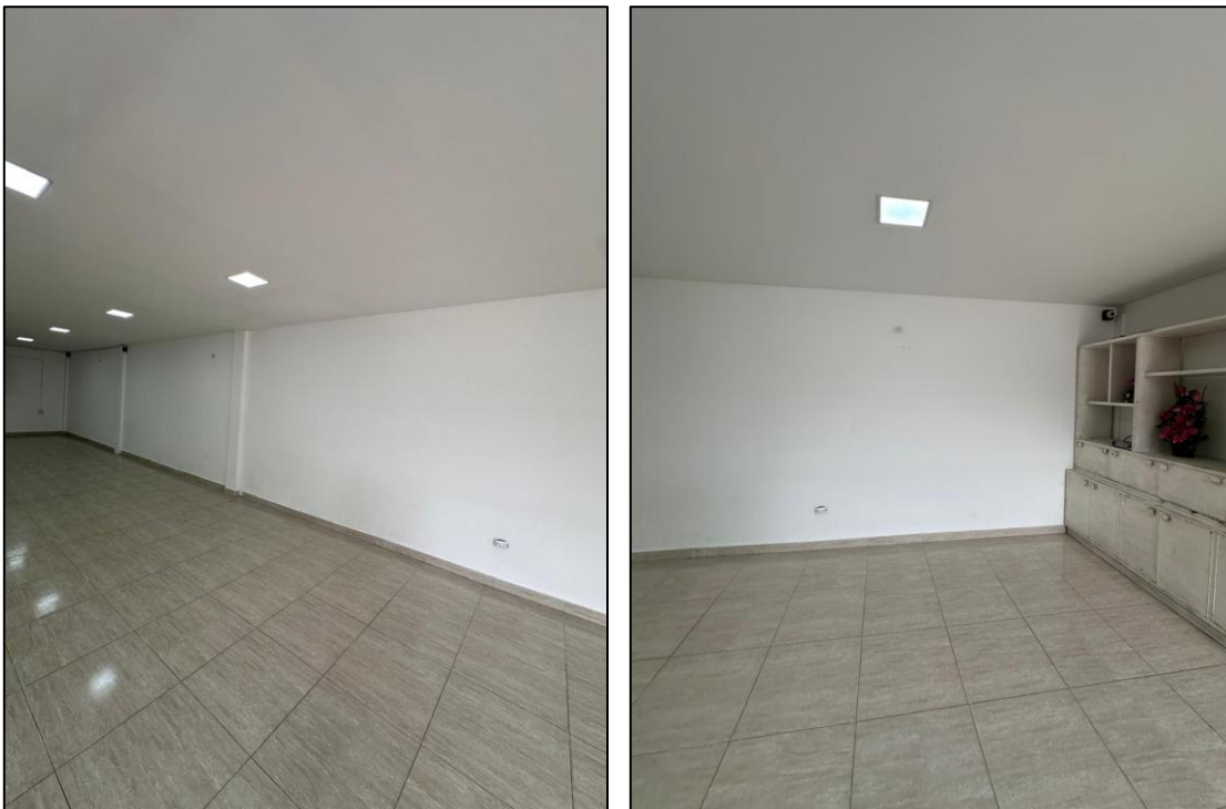
Ilustración 24: Terminación salón audiovisuales muros
