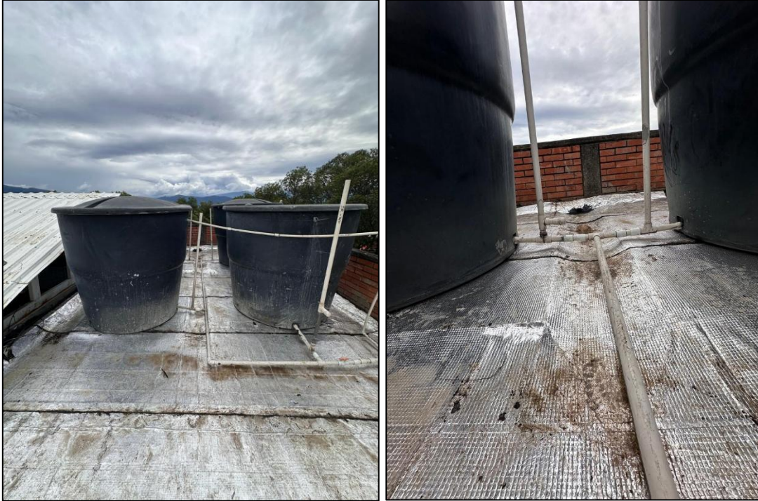
Ilustración 9: Manto asfáltico sobre "poyos" para aislamiento de tanques
