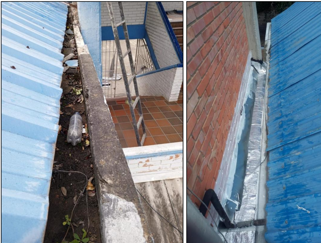
Ilustración 14: Canal escaleras, limpieza e impermeabilización.
