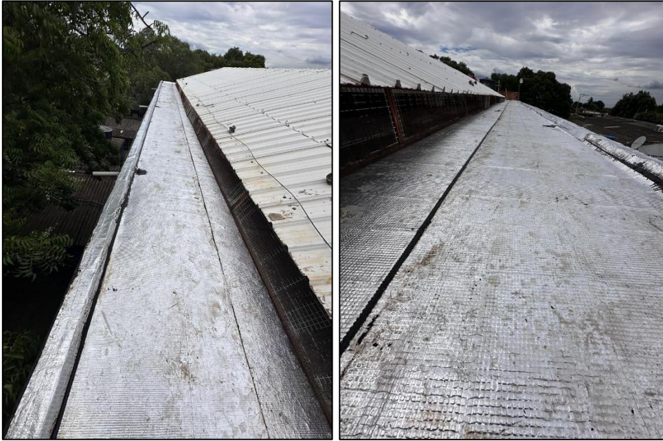
Ilustración 7: Aplicación de emulsión asfáltica e instalación de manto asfáltico
