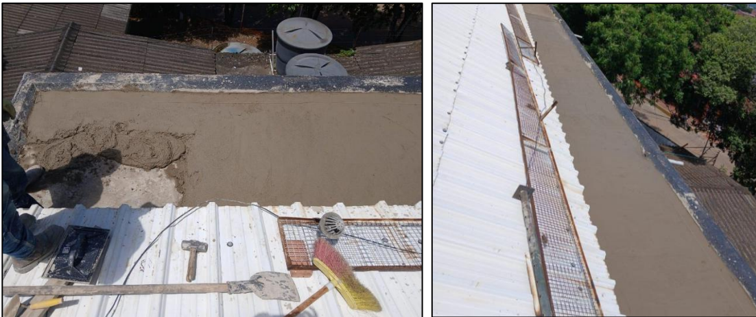
Ilustración 4: Fundida de mortero de nivelación con desnivel
