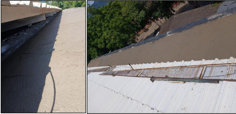
Ilustración 5: Fundida de mortero de nivelación con desnivel
