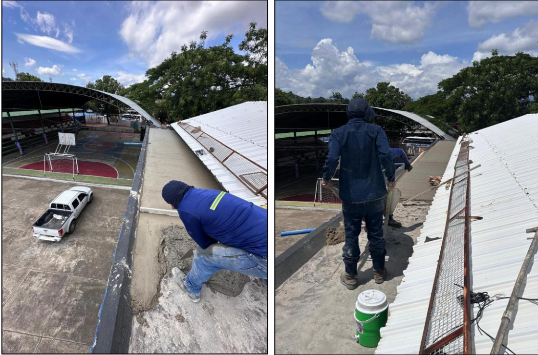
Ilustración 3: Fundida de mortero de nivelación con desnivel
