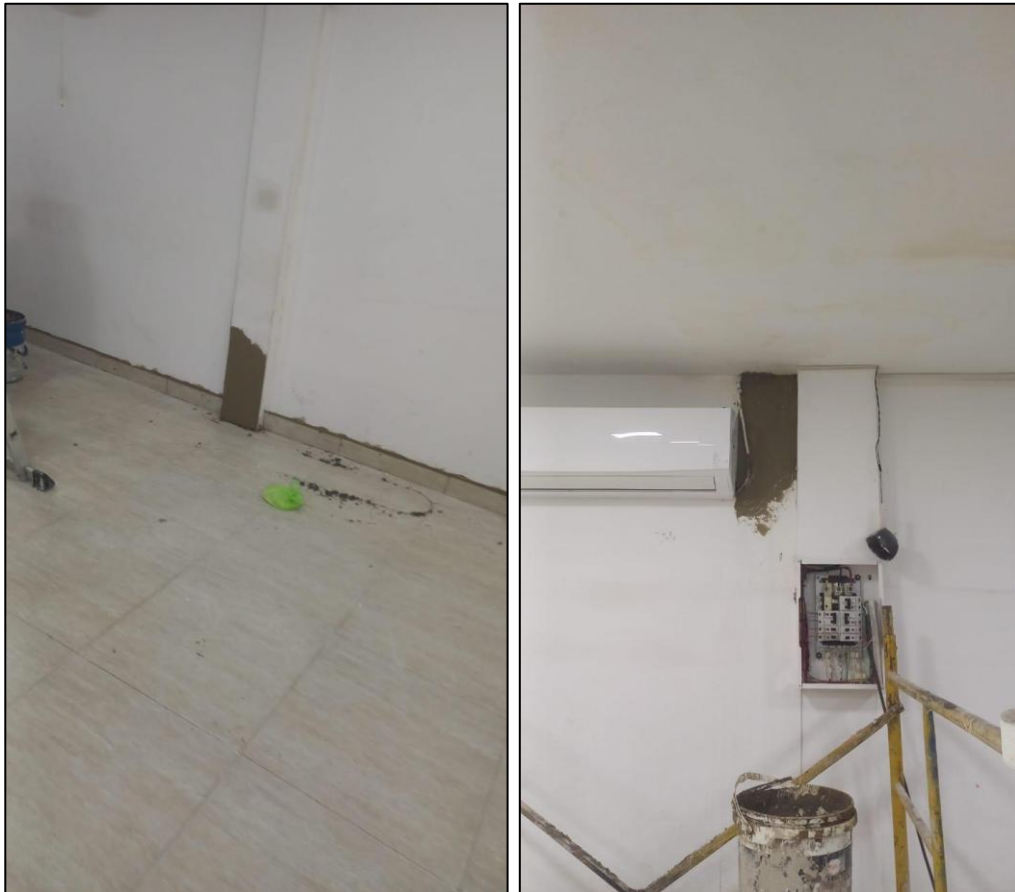
Ilustración 18: Detalles resanados
