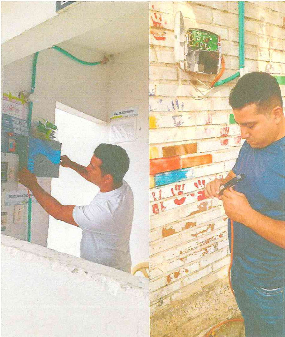
Mantenimiento impulsor cerca eléctrica sede doña nidia y sede principal
